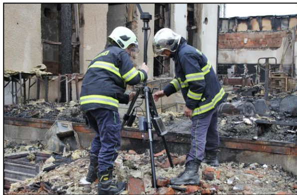
Instalace termovizní kamery v areálu požárem poškozeného výrobního provozu
